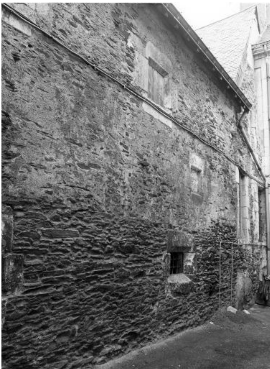
Aile postérieure gauche : élévation postérieure nord-est.
