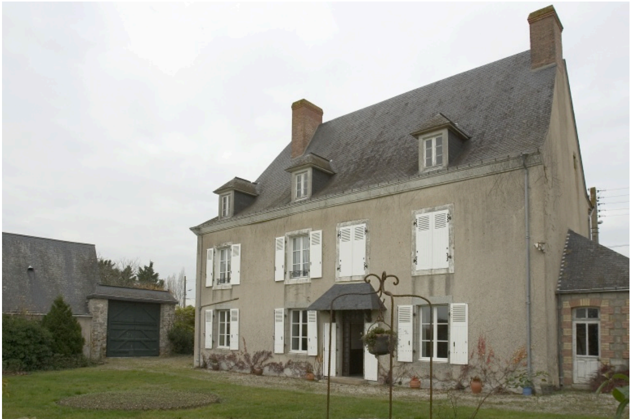
Le logis vu depuis le sud-est.
