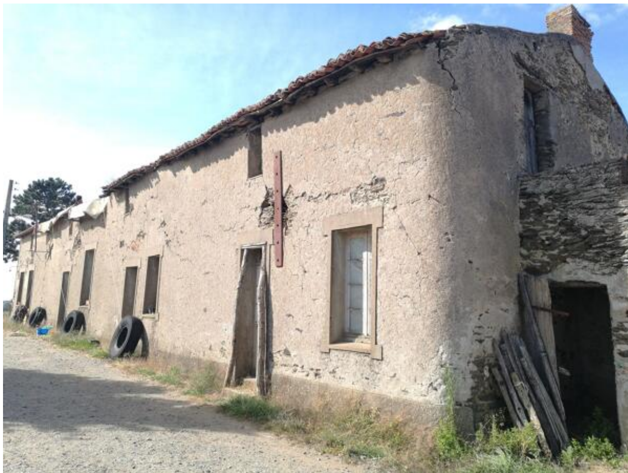
La Voisinière. Vue d'ensemble de la longère.
