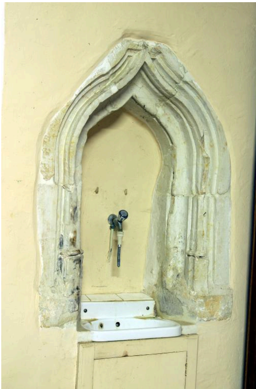
La niche située dans le mur nord de la sacristie.
