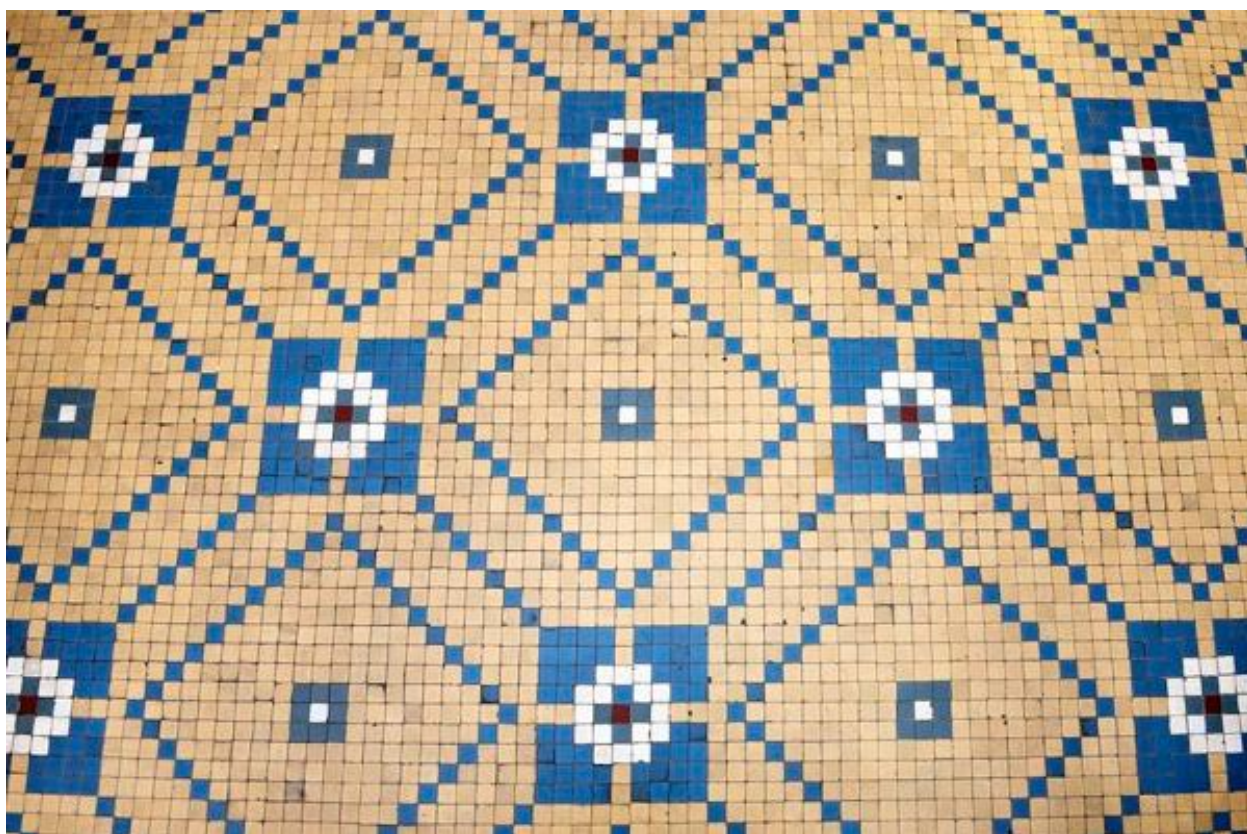
Détail du carrelage.
