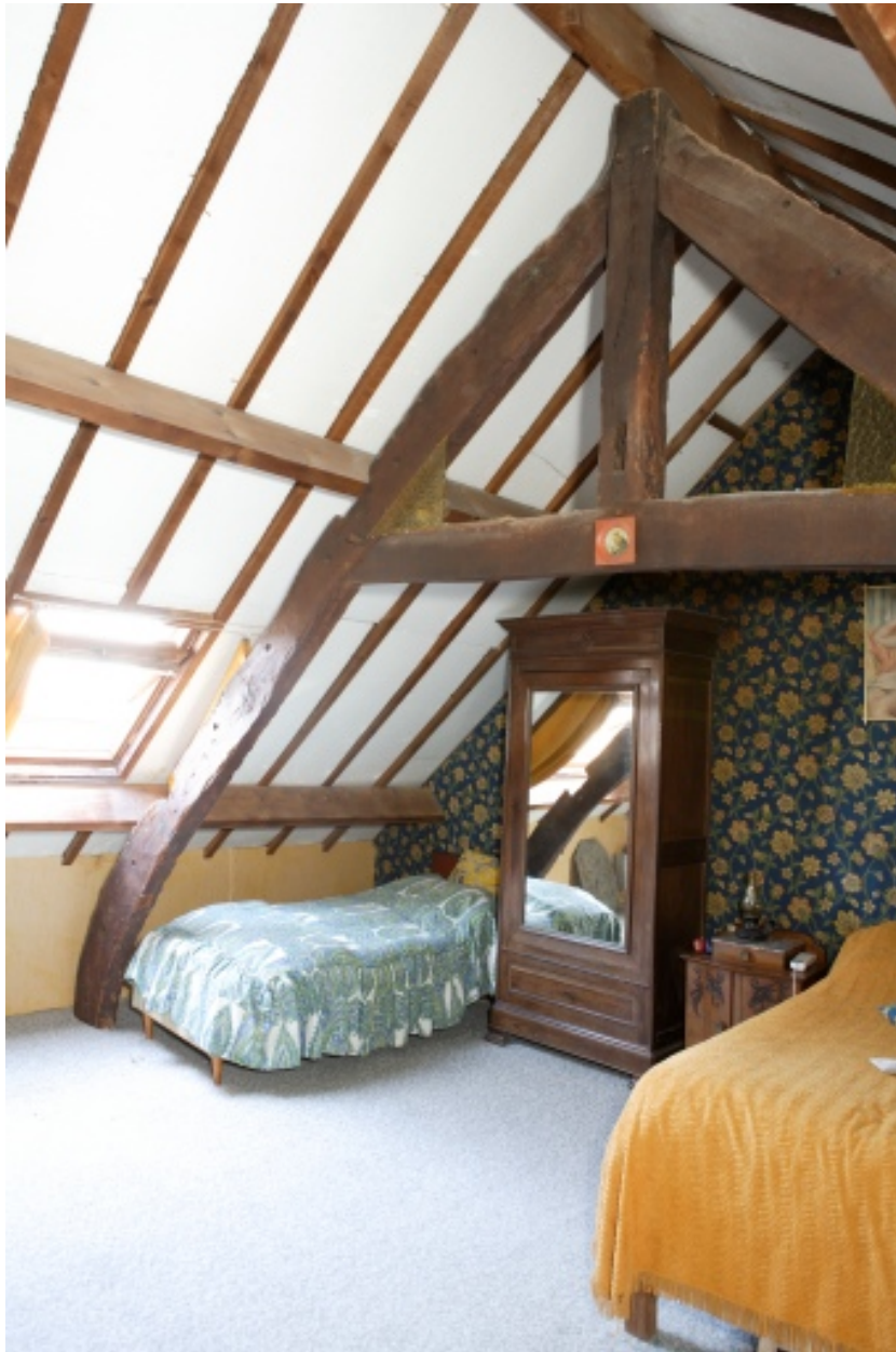
Vue de la charpente (6 rue de l'Aha).
