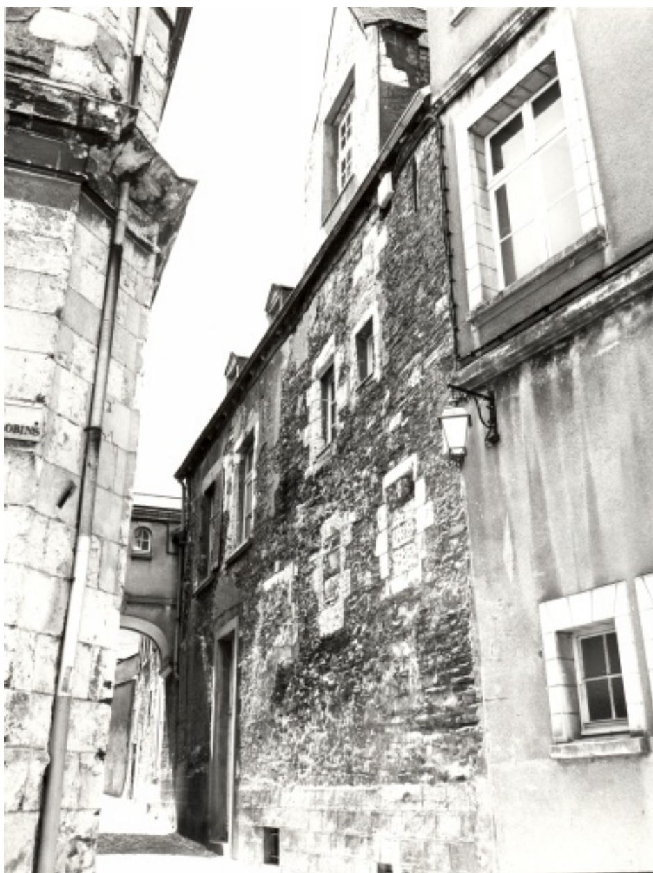
Logis antérieur droit, élévation sur rue (postérieure).
