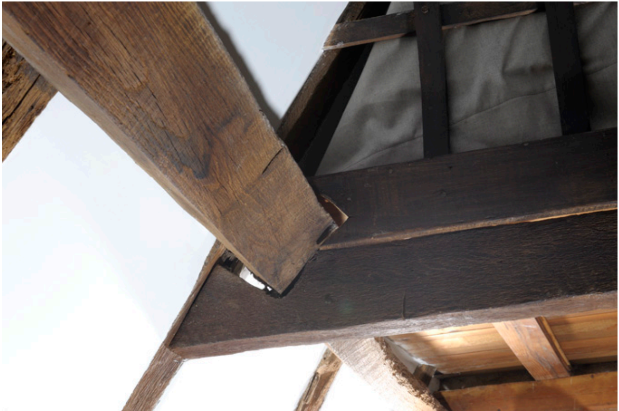
Comble : vue de la charpente, détail du faux-entrait portant panne sous arbalétrier.
