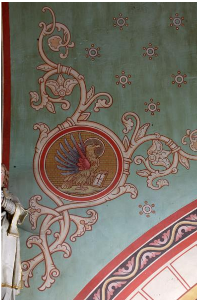
Chœur, travée droite, voûte, côté sud : aigle de saint Jean.
