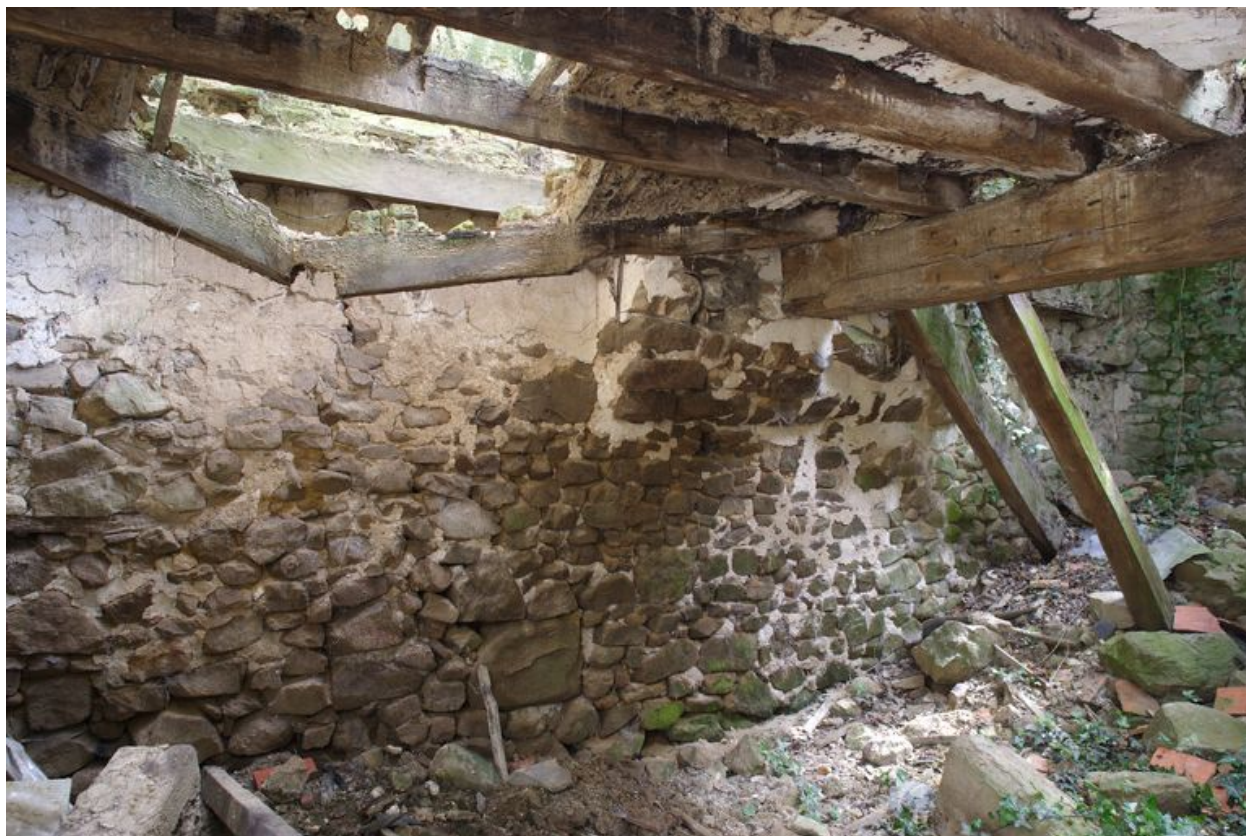
Rez-de-chaussée, pièce nord : le mur nord (?)
