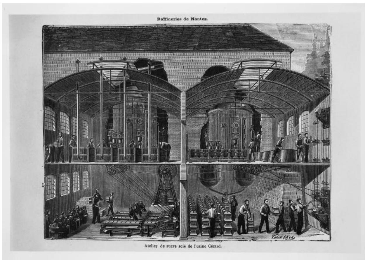
Atelier de sucre scié. A l'arrière plan, deux appareils à cuire. Au 1er plan, à l'étage, à droite, turbines d'essorage ou clairçage de la masse-cuite ; au rez-de-chaussée, à droite, sucre en lingots, à gauche machines à scier. 1881.
