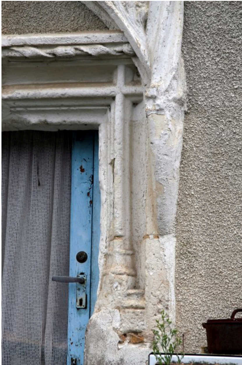
Le logis, la porte d'entrée : piédroit à moulure prismatique.
