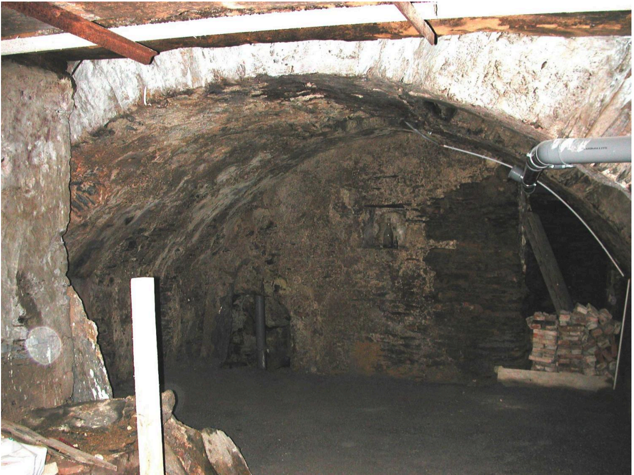
Sous-sol : voûte de schiste en berceau segmentaire située sous la cour, vue en axe nord-sud.
