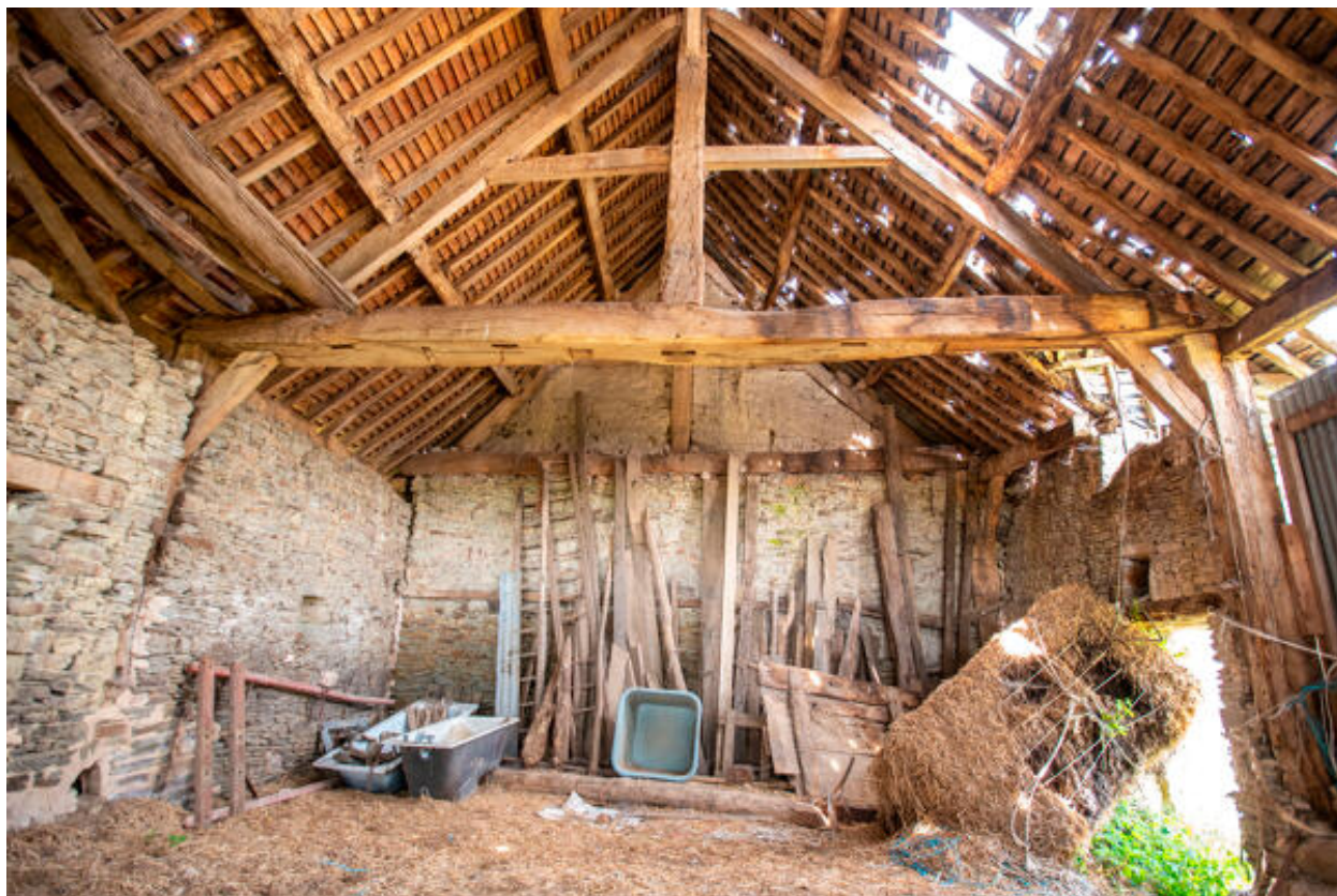
Ferme est, corps de bâtiment ouest, structure à poteaux porteurs.
