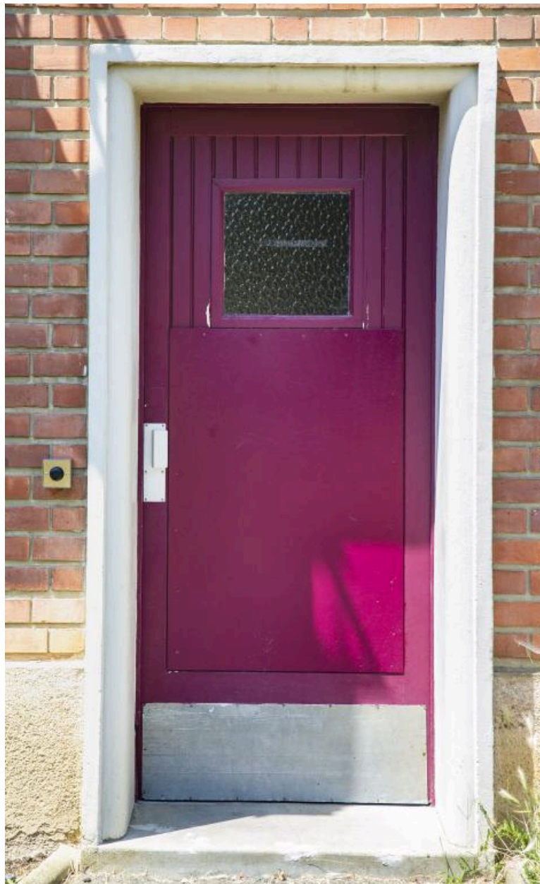
Détail d'une porte sur espace vert du bâtiment B1.
