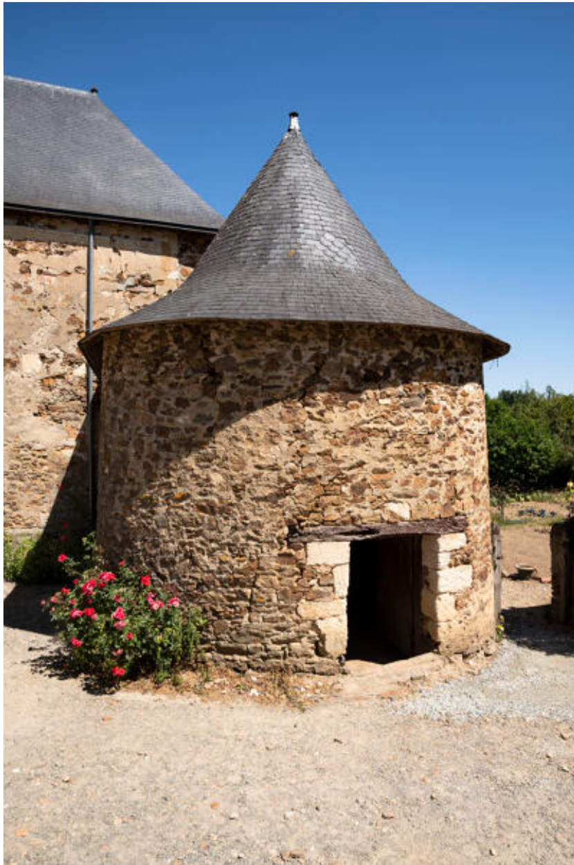
Le bâtiment en abside.
