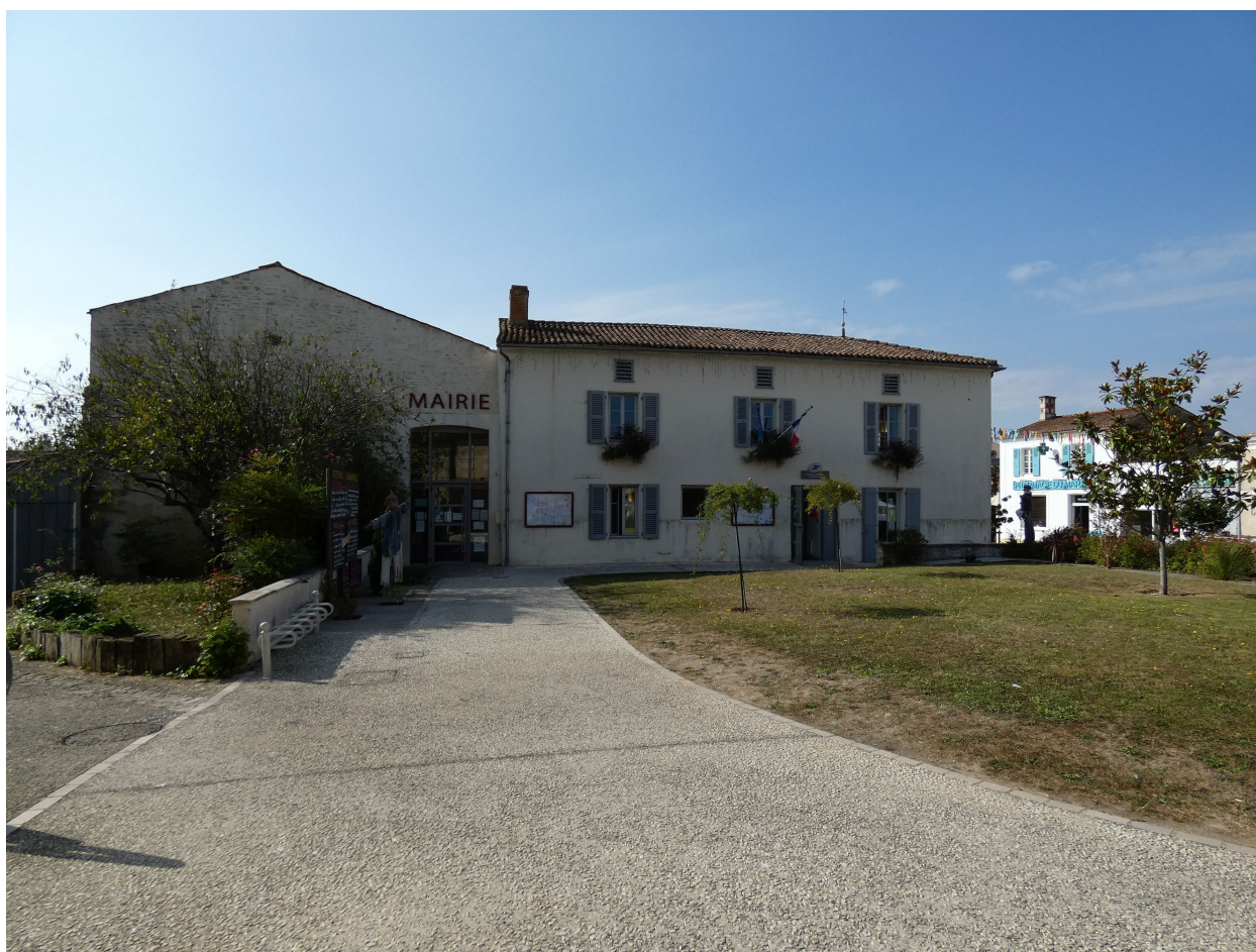
La mairie et les deux corps de bâtiments vus depuis le nord.
