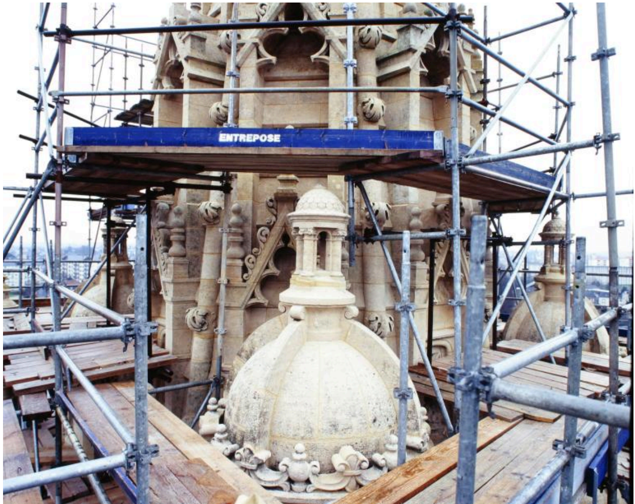
Basilique, clocher : base de la flèche et détail du lanterneau sud-ouest
