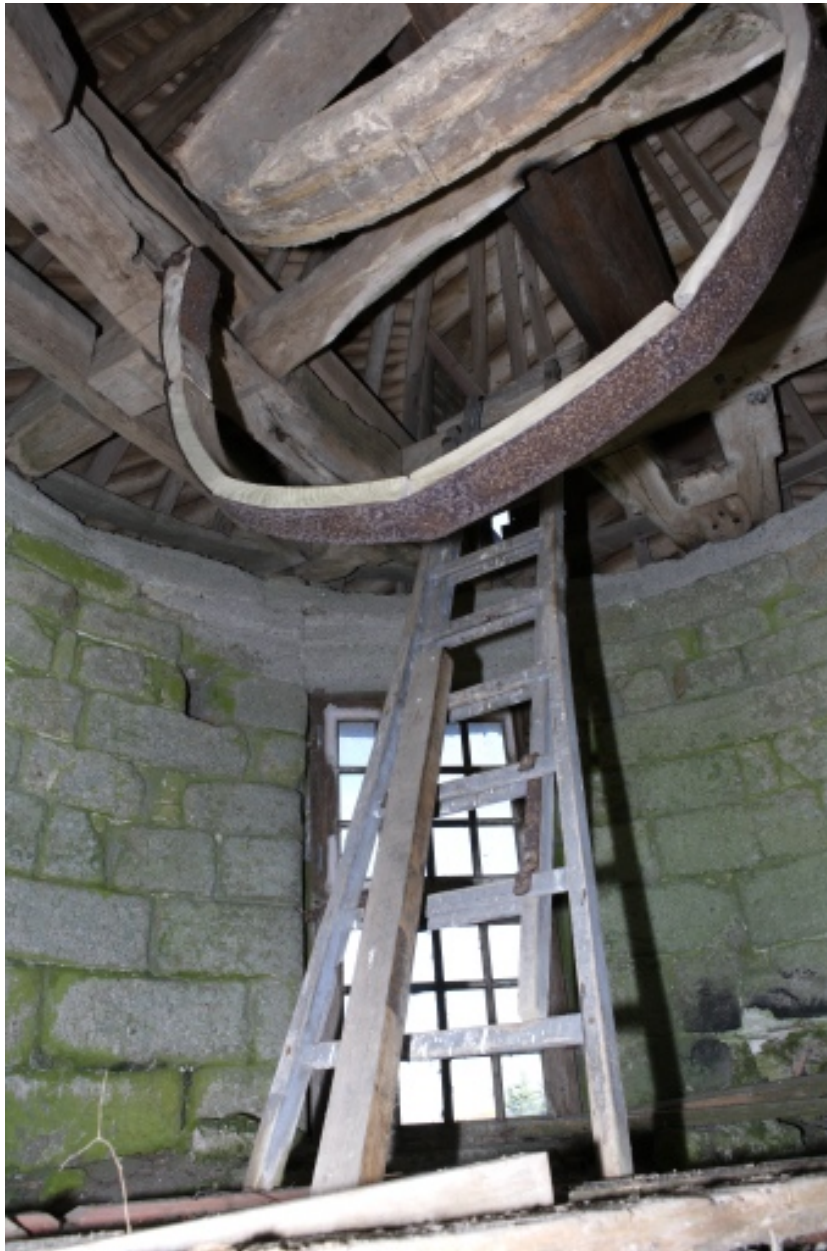
Vue intérieure de la coiffe ; la bande du frein.
