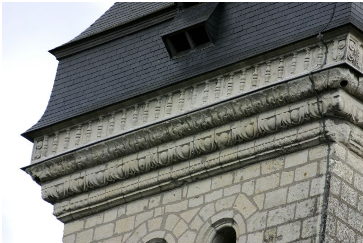
Le clocher : détail de la corniche.
