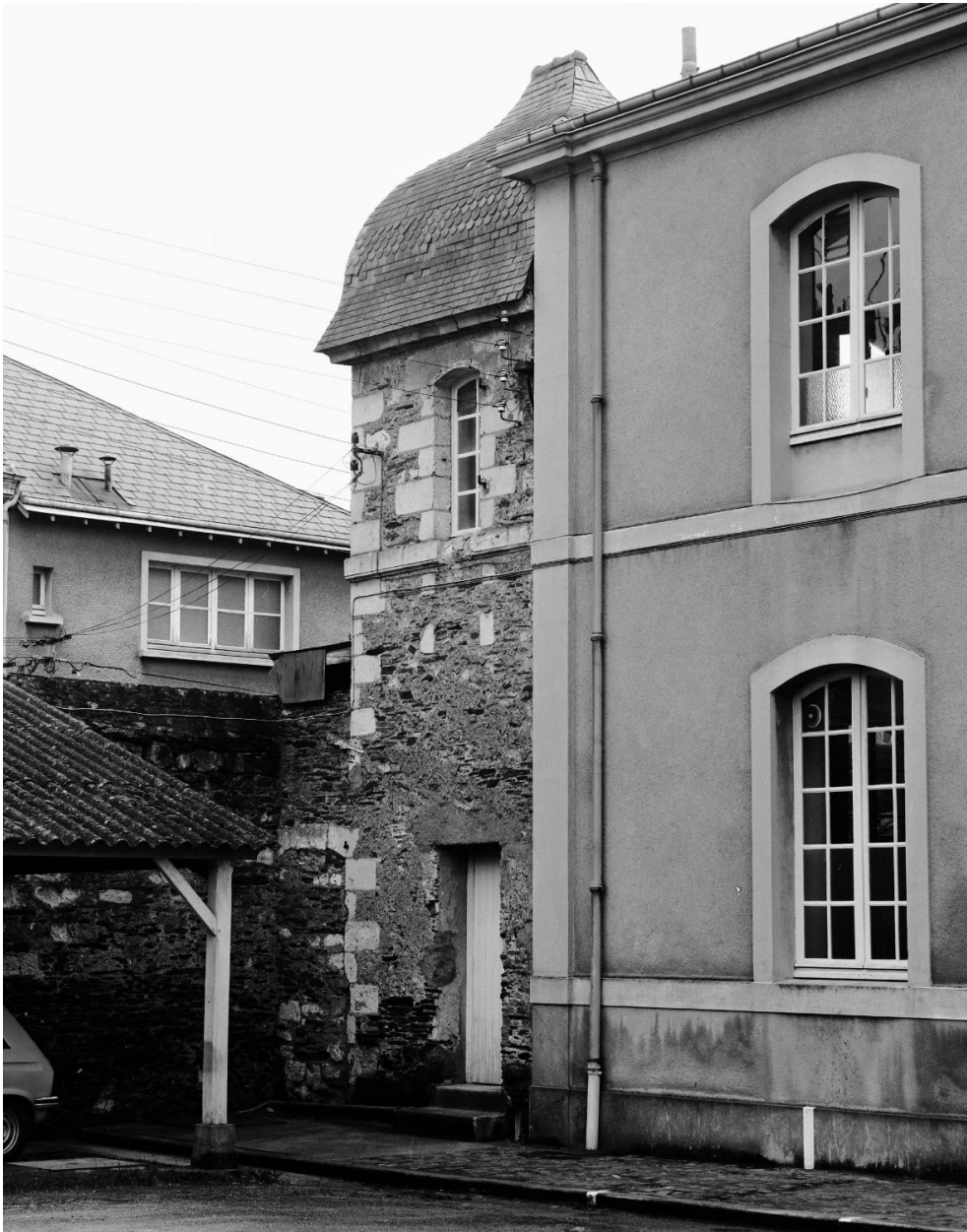
Ancienne cour d'entrée de la marquise de Férolle (41 rue Lionnaise), pavillon jouxtant à l'est l'aile double des parloirs et logis de la marquise : élévation sur cour.
