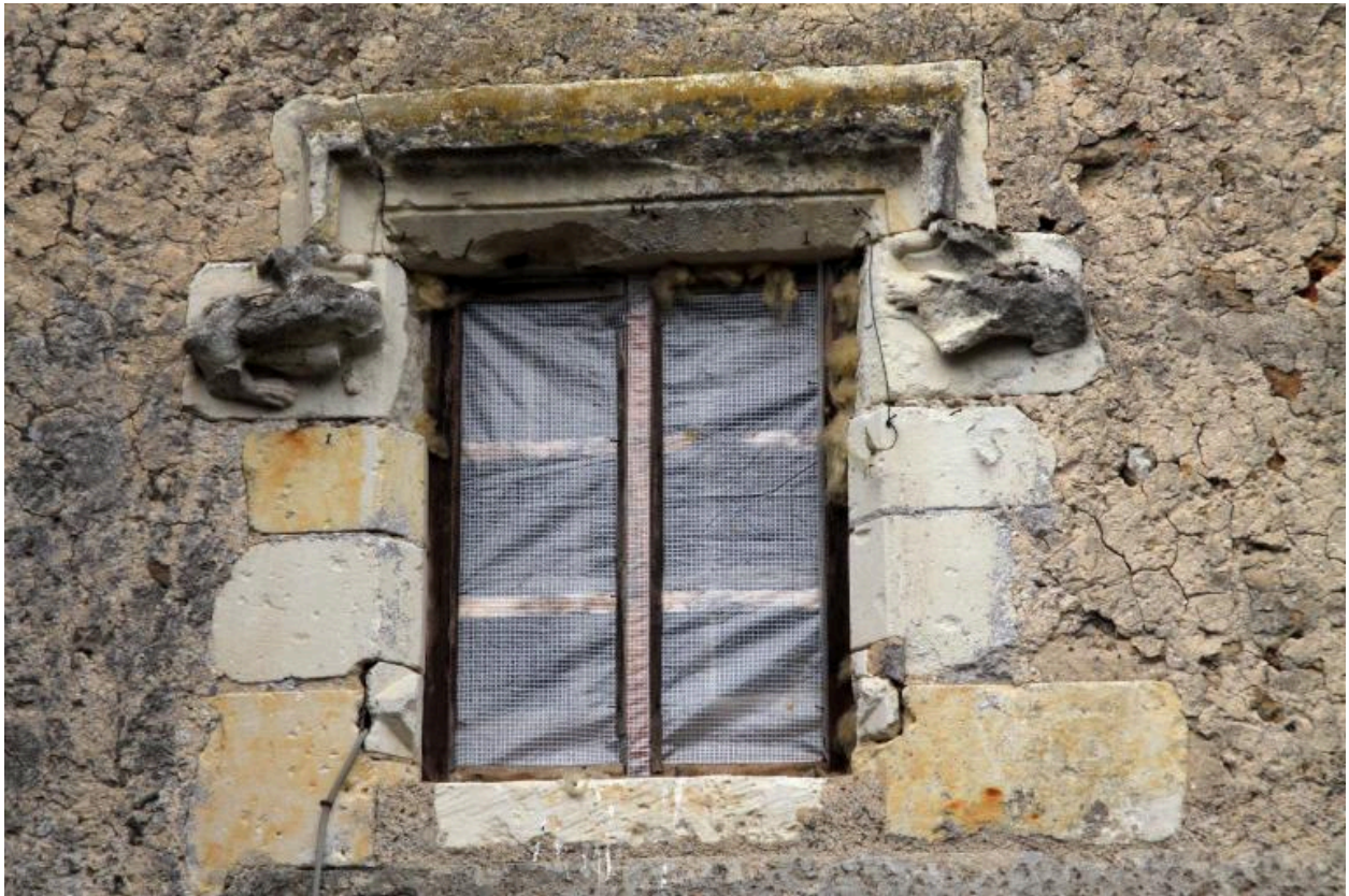
Le logis, façade postérieure, demie travée : linteau de la baie du rez-de-chaussée.
