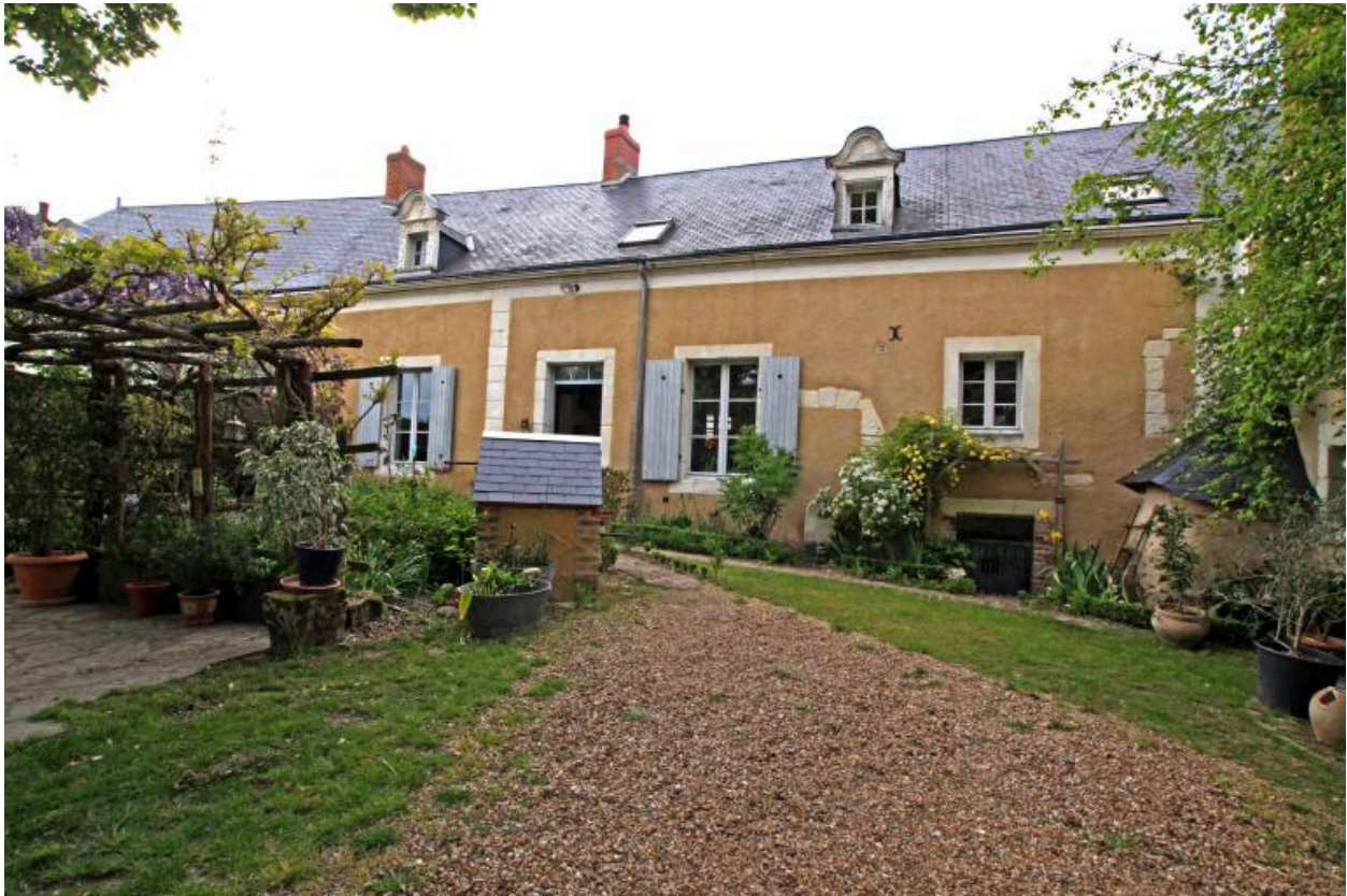
Maison, façade sur cour.
