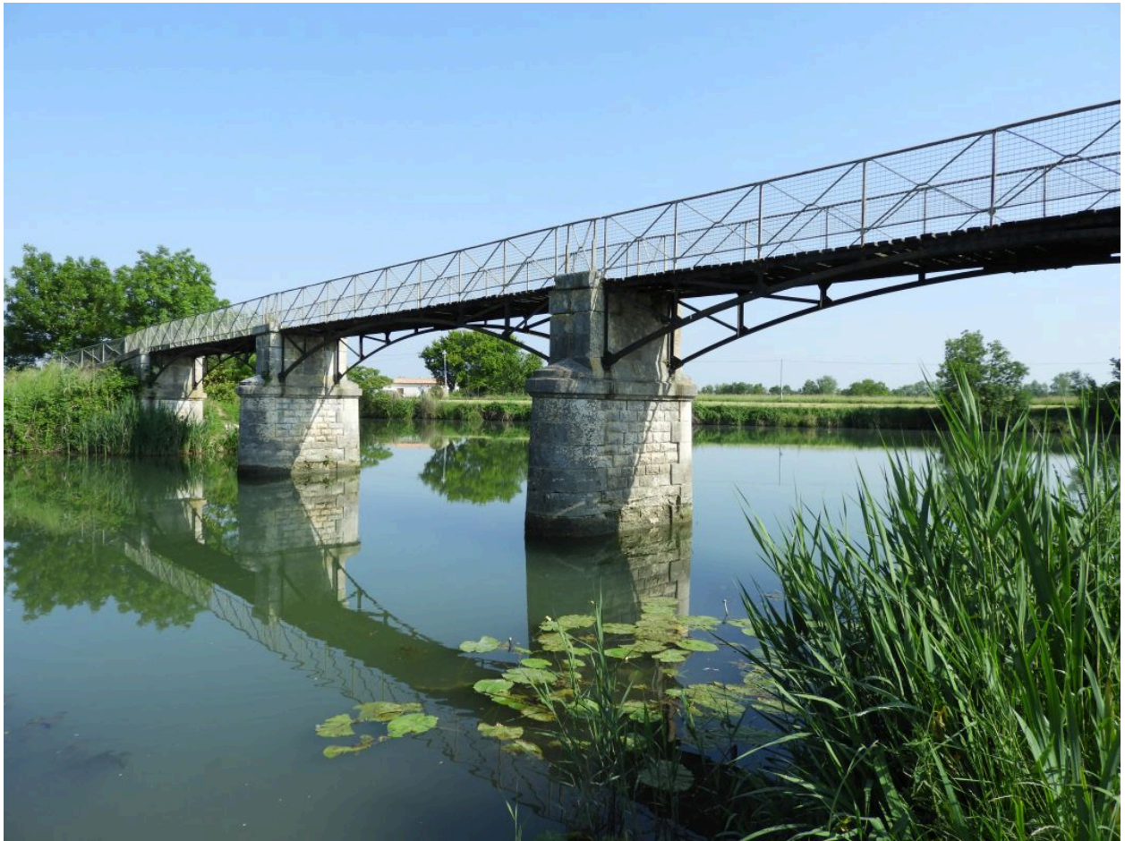
La passerelle vue depuis la rive gauche de la Vieille Sèvre, à Saint-Jean-de-Liversay, au sud-est.
