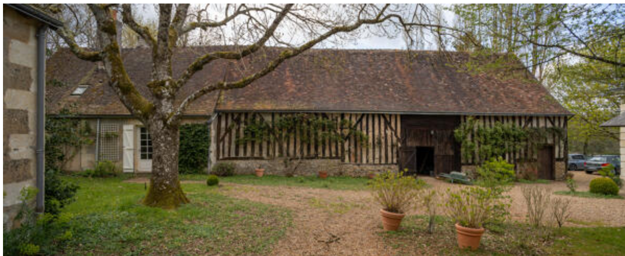
Grange-étable-remise et logement : façade sur cour.
