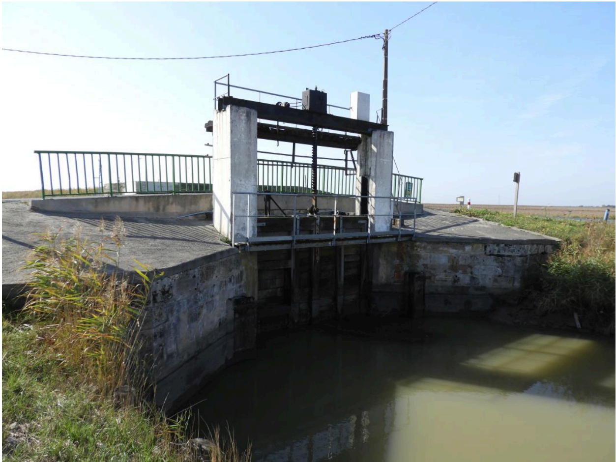
La porte, côté amont, vue depuis le nord-est.
