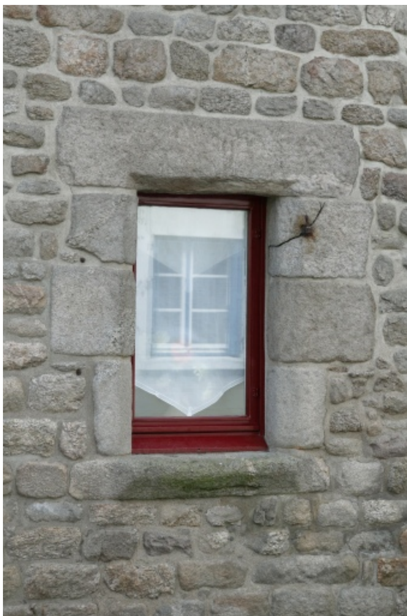
Façade sur rue, détail d'une fenêtre.
