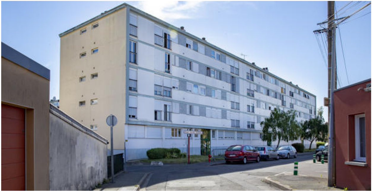
Vue de la façade principale de l'immeuble rue Amboise Paré.
