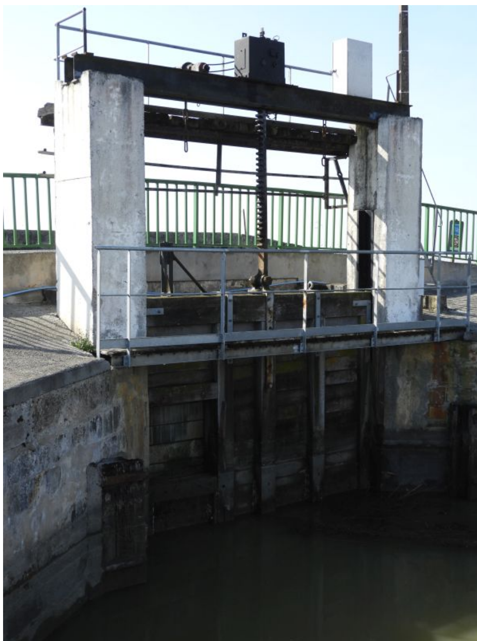
La vanne verticale en arrière de la porte, soutenue par le portique et la crémaillère.
