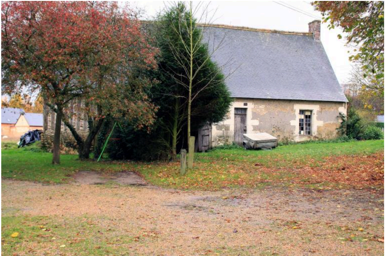
La grange fermant le côté sud de la cour : habitation dans le prolongement.
