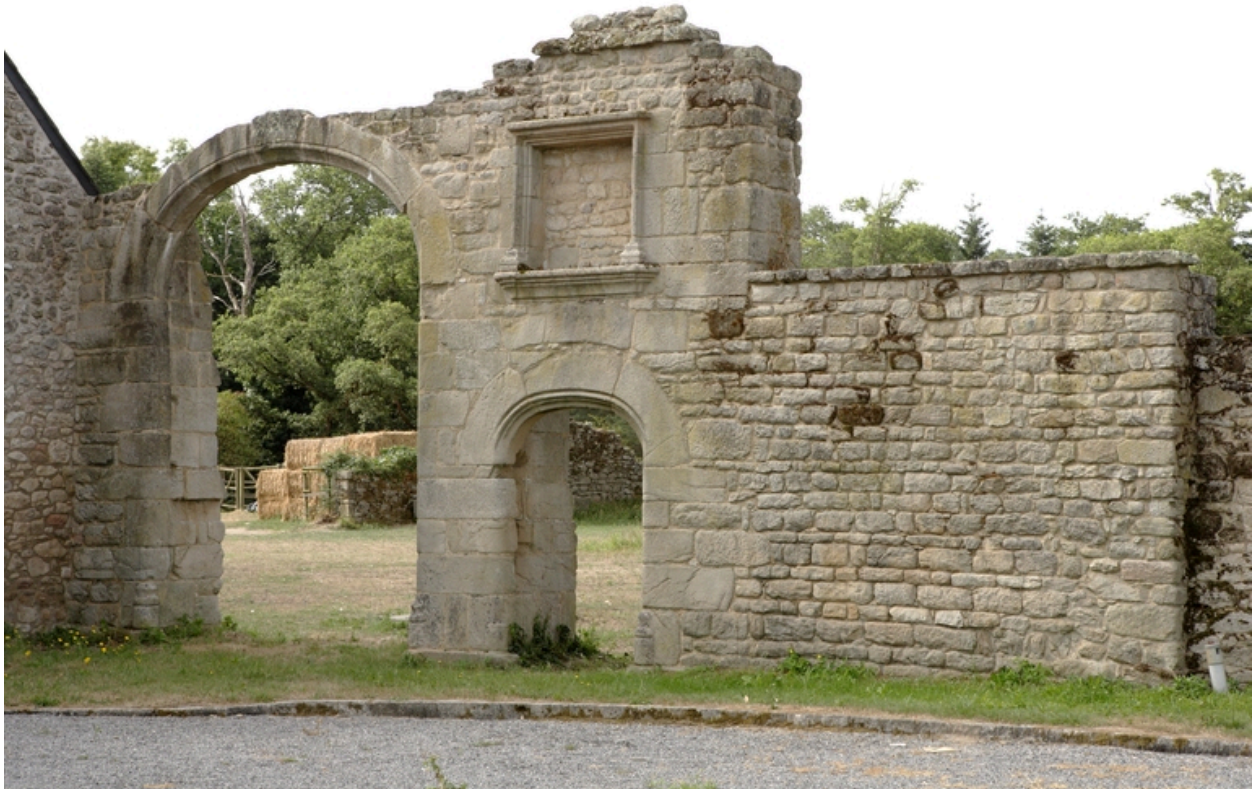
Le portail. Vue depuis le nord.
