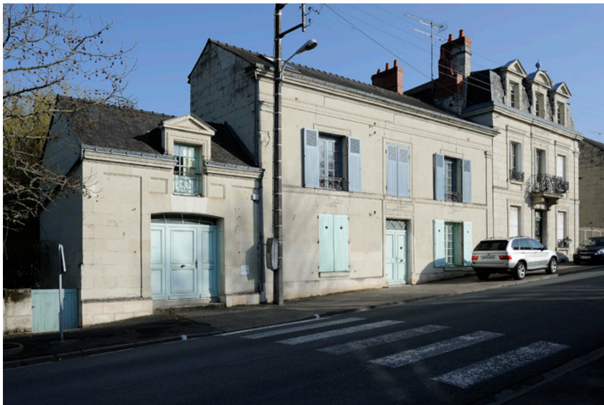
Avenue Rochechouart (60), maison et dépendances (2e moitié du XIXe siècle), construite sur le nouveau tronçon de voie du bourg aux Roches (1839-1840).
