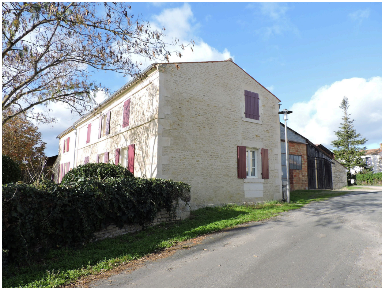
Le logis vu depuis le sud-est.
