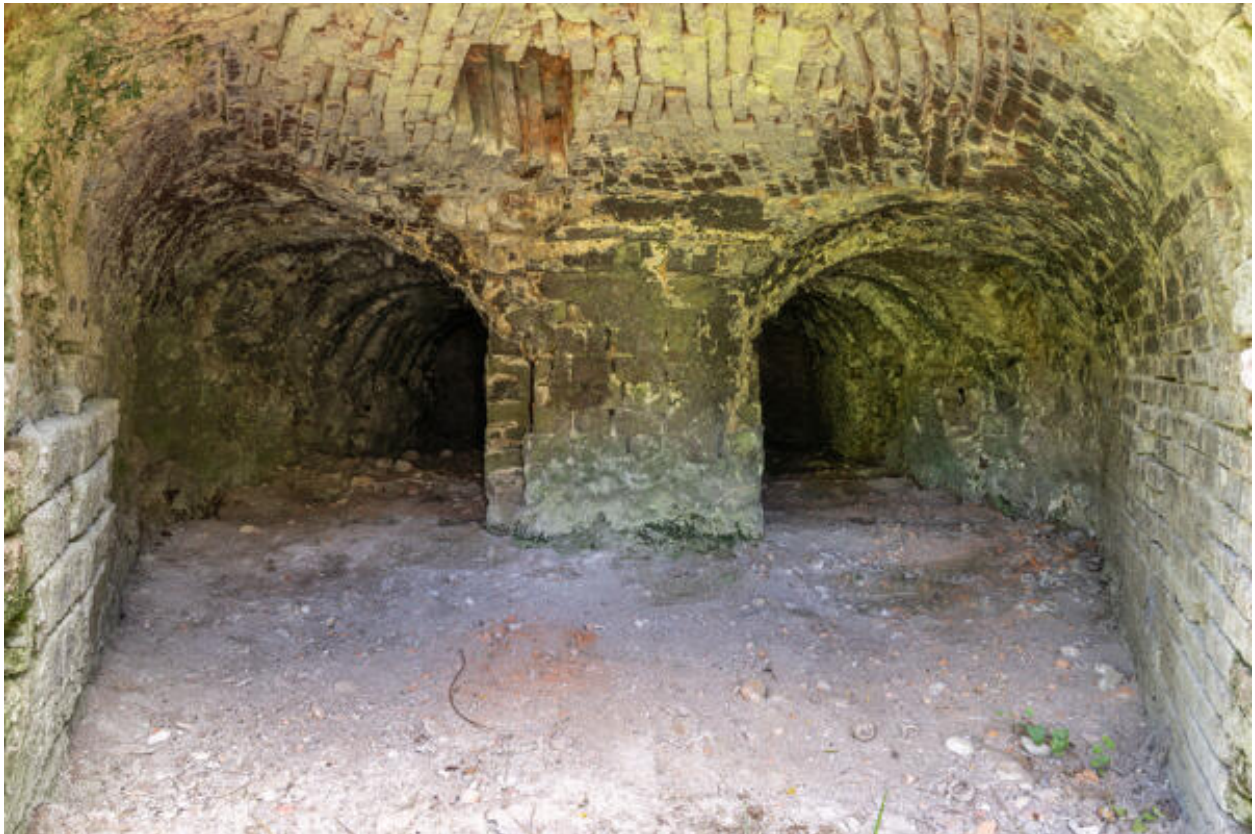
Le four : intérieur de l'alandier.
