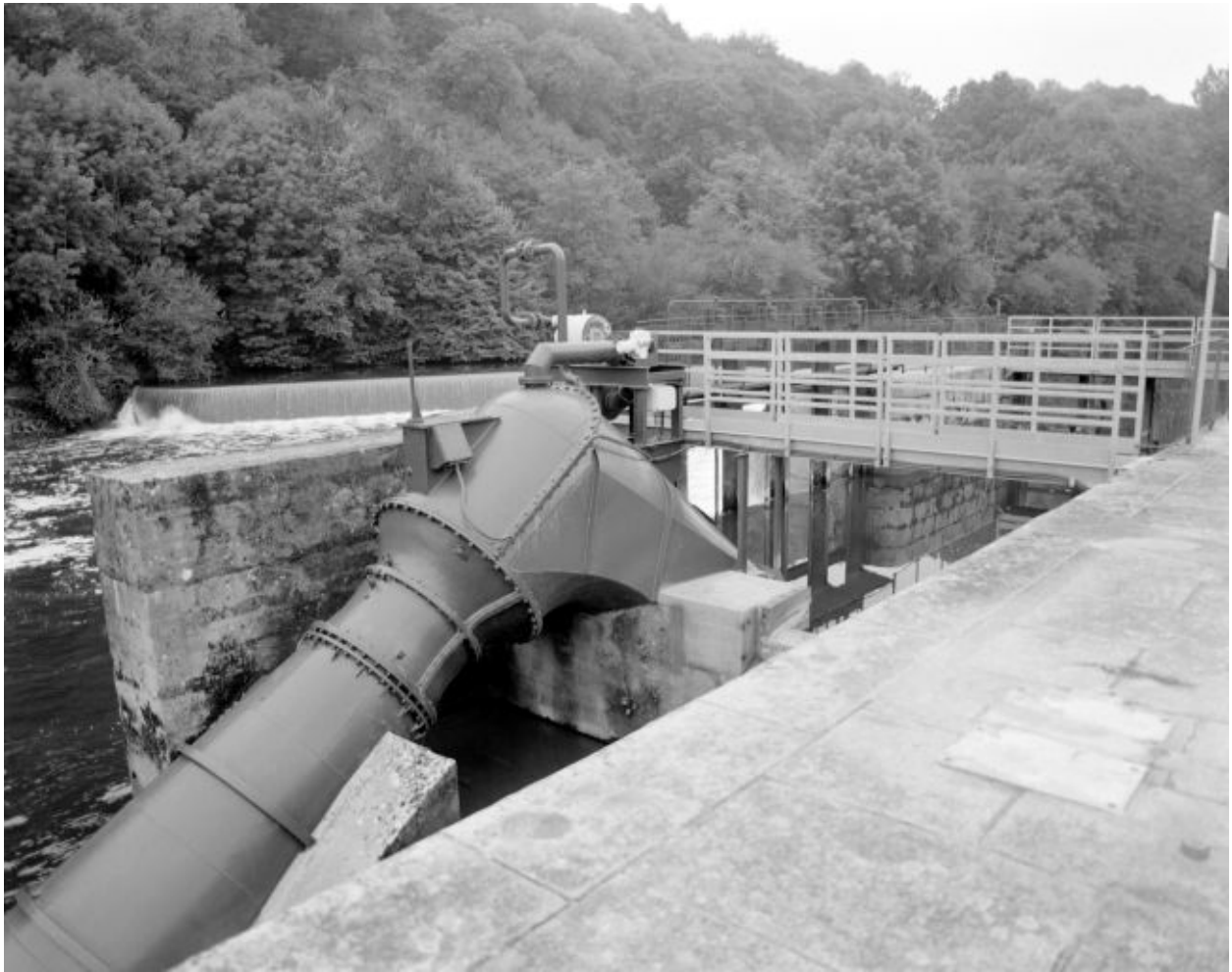
La maison éclusière et le transformateur électrique.
