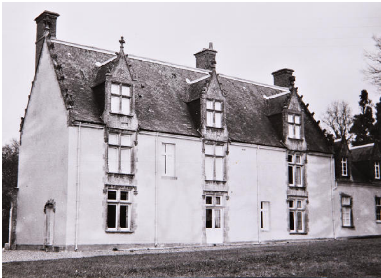
Vue ancienne du logis de volume avec façade nord.
