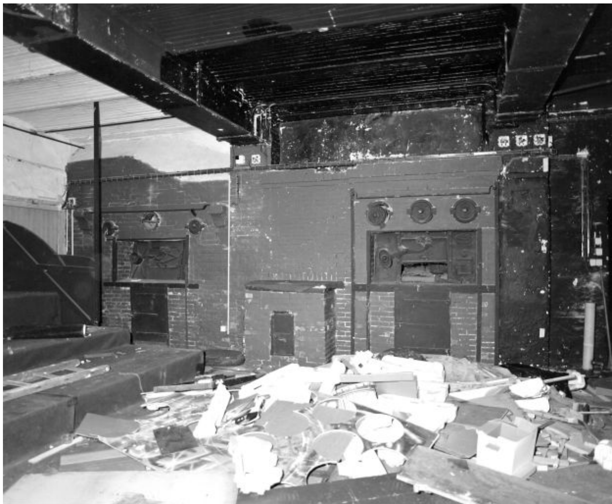
Couvent, aile nord-ouest, four à pains : vue d'ensemble.
