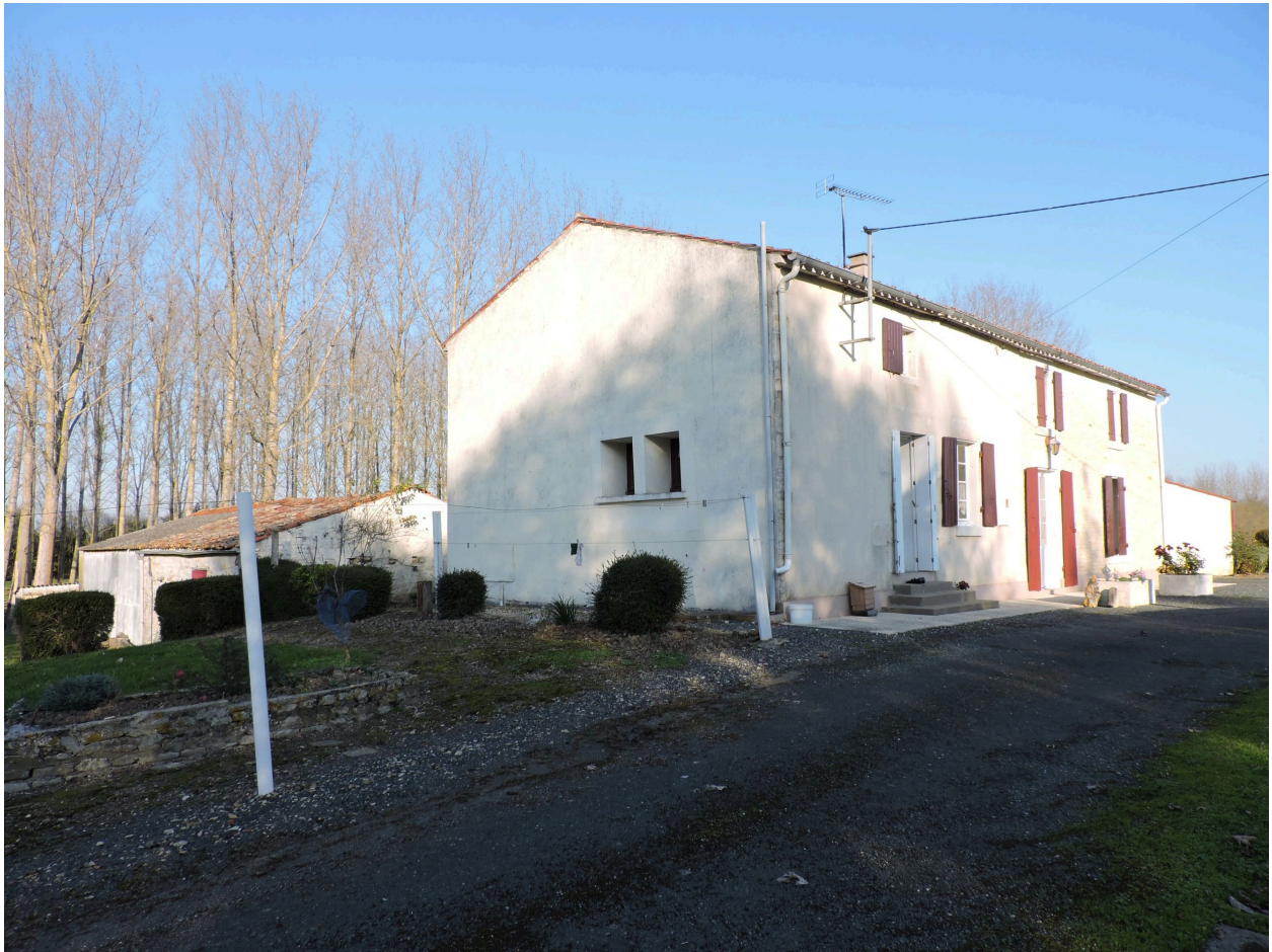
Le logis et l'étable vus depuis le sud-ouest.
