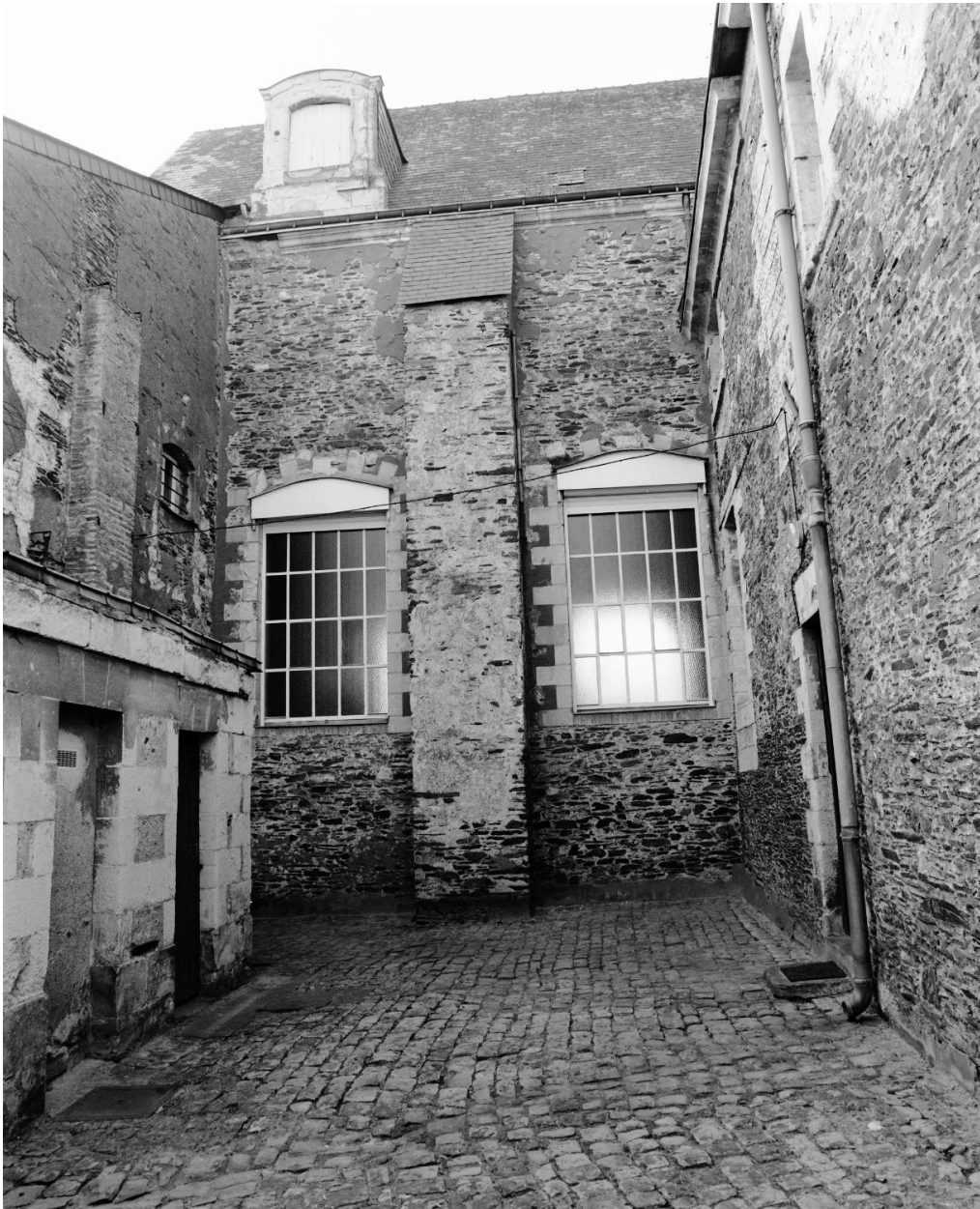
Choeur des religieuses : façade nord.
