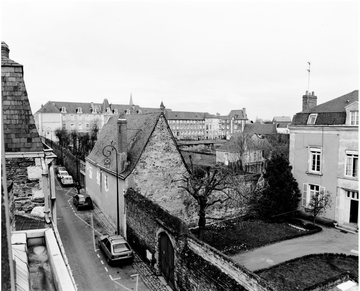
Vue de situation au sud-est, depuis les combles du 2 rue de la Harpe. Au premier plan, maison n° 6 bis rue Vauvert.
