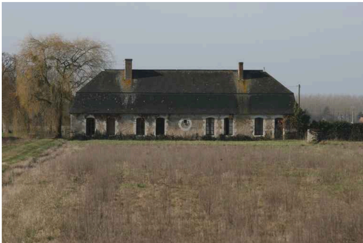
Logements à l'ouest.
