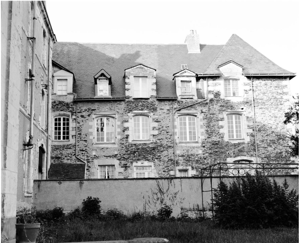
Aile sud du bâtiment de l'infirmerie : vue d'ensemble de l'élévation sud, depuis le jardin du pensionnat.
