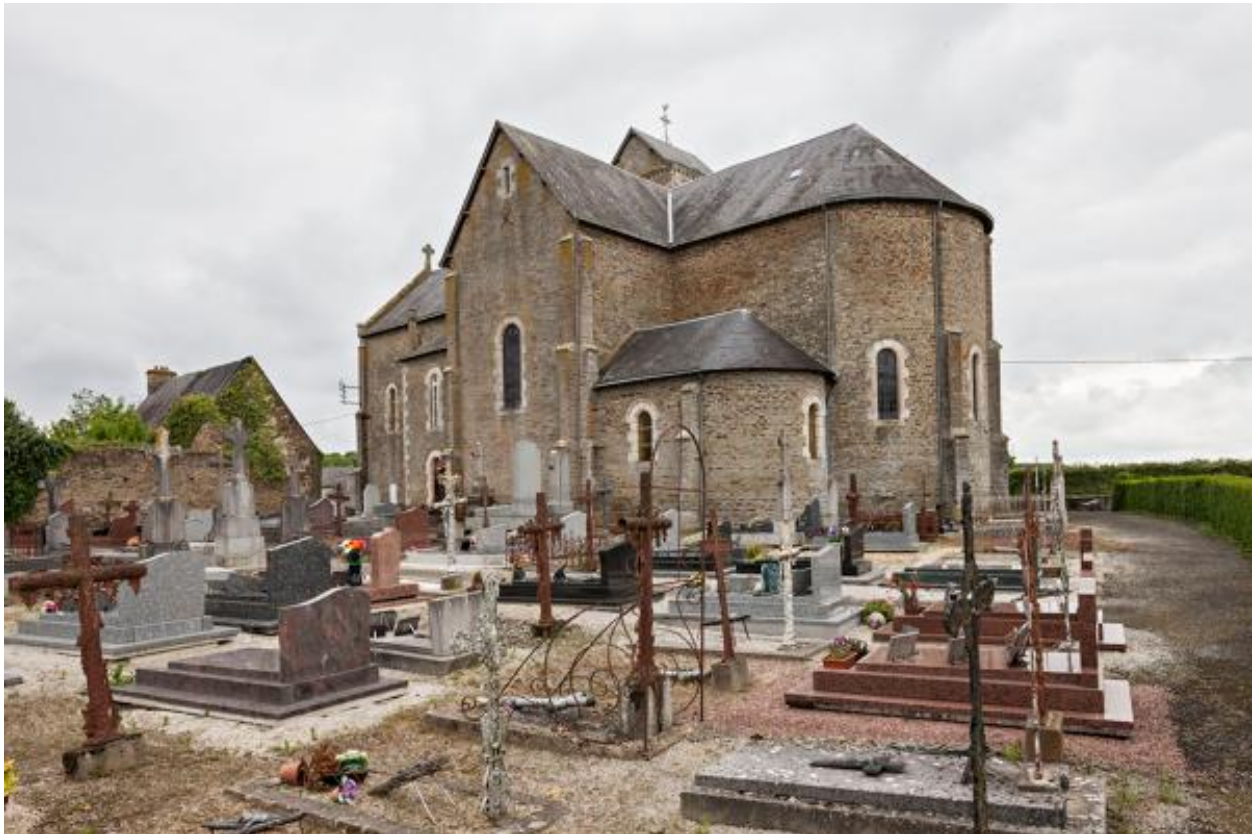
Vue d'ensemble depuis l'est de l'église de la Baroche-Gondouin.
