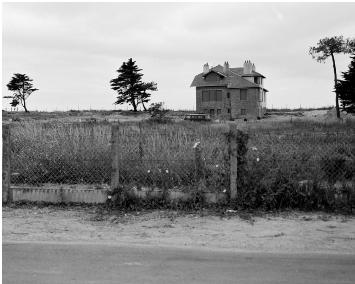
Vue d'ensemble prise du nord-est, depuis la route du Collet.
