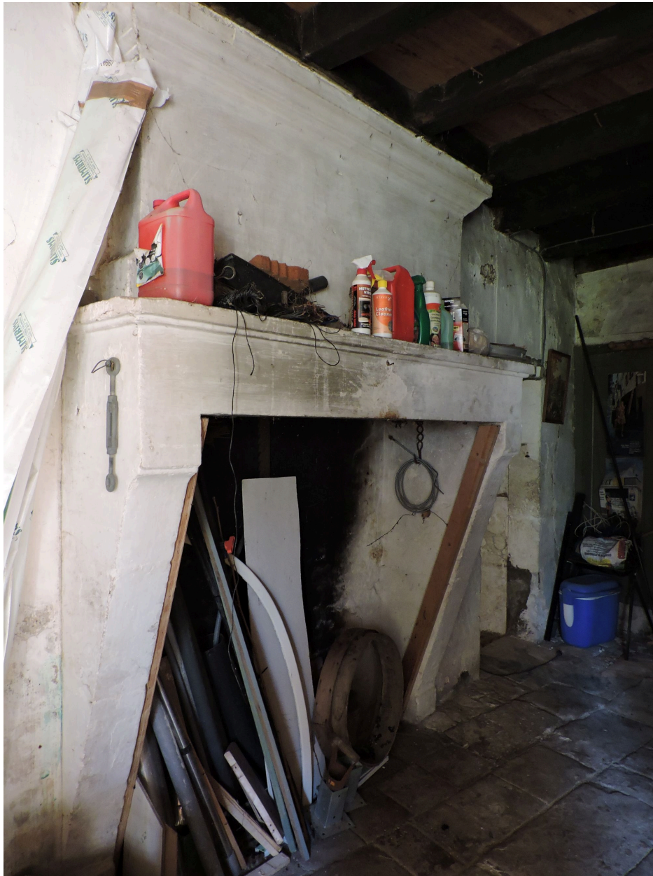
Cheminée dans la pièce de service à l'ouest du logis.
