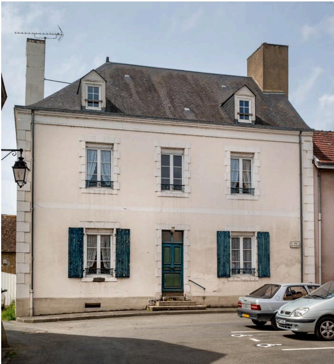
Une demeure du XIXe siècle, rue des Piliers.
