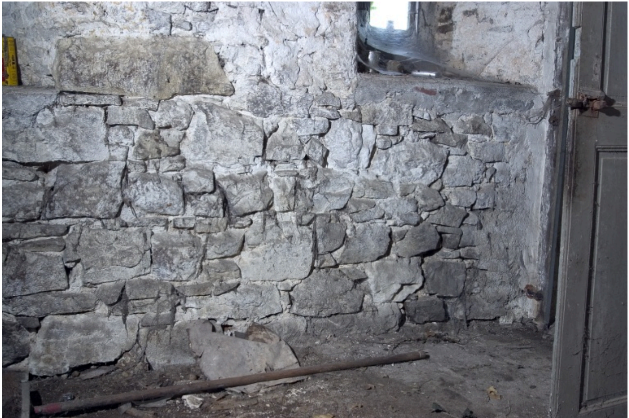
Intérieur du corps nord, rez-de-chaussée, cave est : détail du mur nord.
