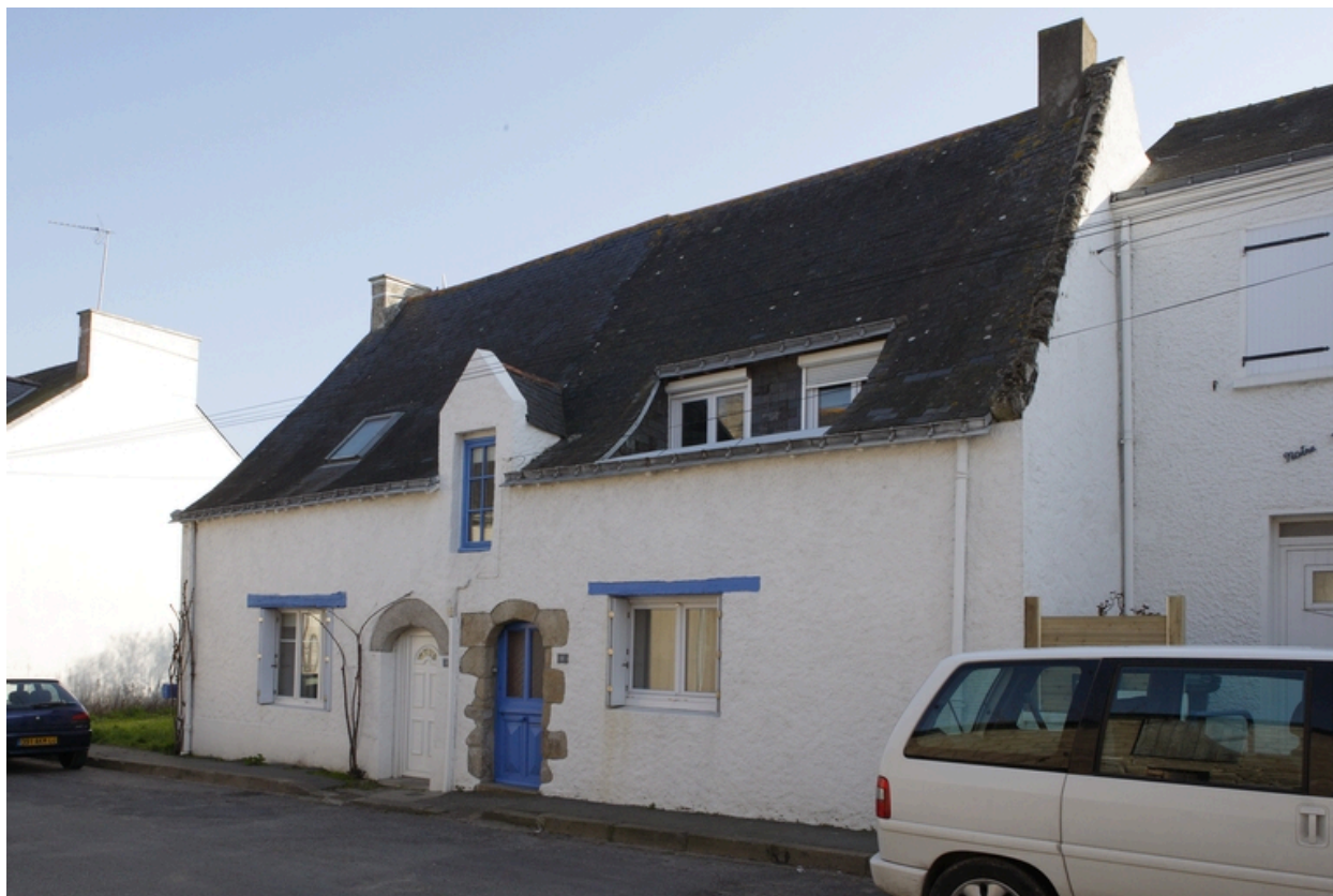
Vue des n° 6 et 8 rue de la Croix-Sérot.
