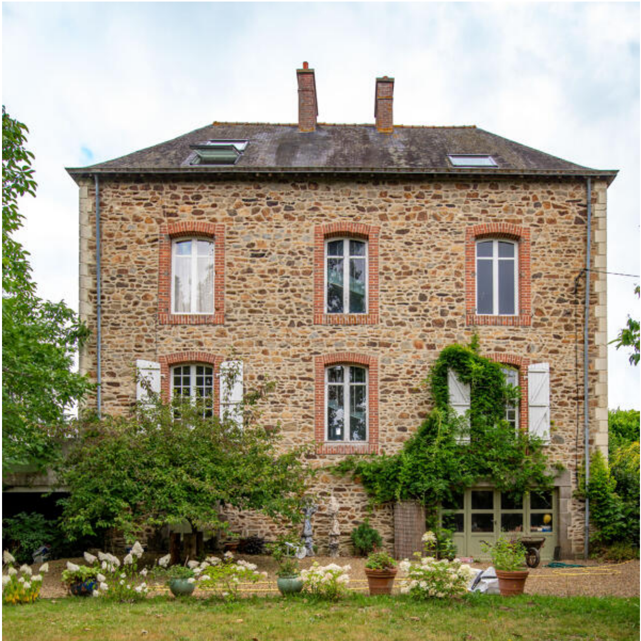
La façade postérieure.
