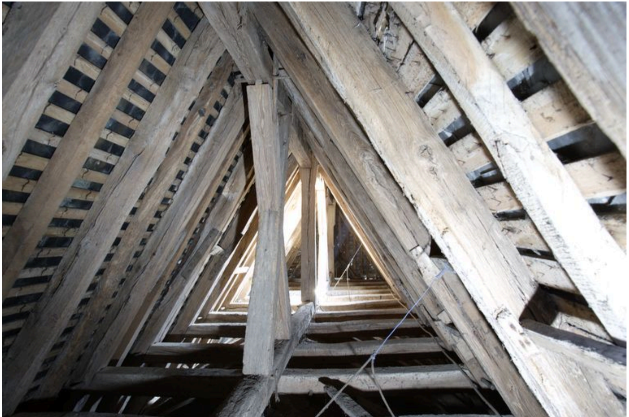
Charpente de la nef : vue d'ensemble depuis l'ouest.
